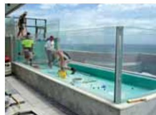
La piscina è composta su tre lati da blocchi di PLEXIGLAS®, permettendo così di godersi il panorama anche sott'acqua.
