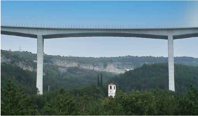
Viadukt Črni Kal, Slovenia
