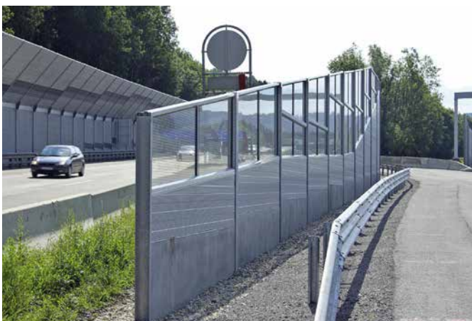
Noise barrier, A1, Steinhäusl PLEXIGLAS® Soundstop GS CC Forster Metallbau Gesellschaft m.b.H.
