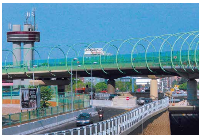
Noise barrier, Piazza Maggi, Milano PLEXIGLAS® Soundstop XT Technical, Provaglio (Brescia)
