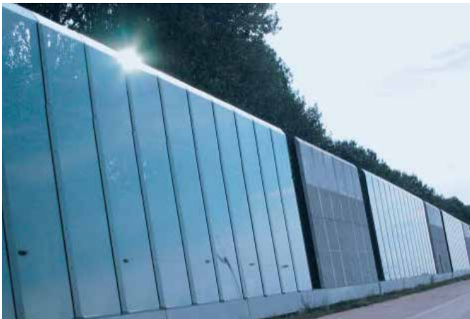
Noise barrier, A15, Gorinchem PLEXIGLAS® Soundstop XT Heijmans B. V., s'Hertogenbosch und Strukton Betonbouw, Maarsse
