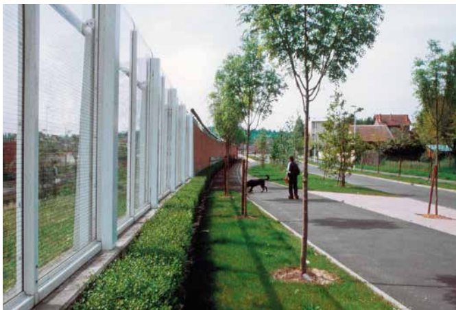
Noise barrier, Boulevard Intercommunal du Parisis PLEXIGLAS® Soundstop GS CC Direction Départementale de l'Équipement, Val d'Oise
